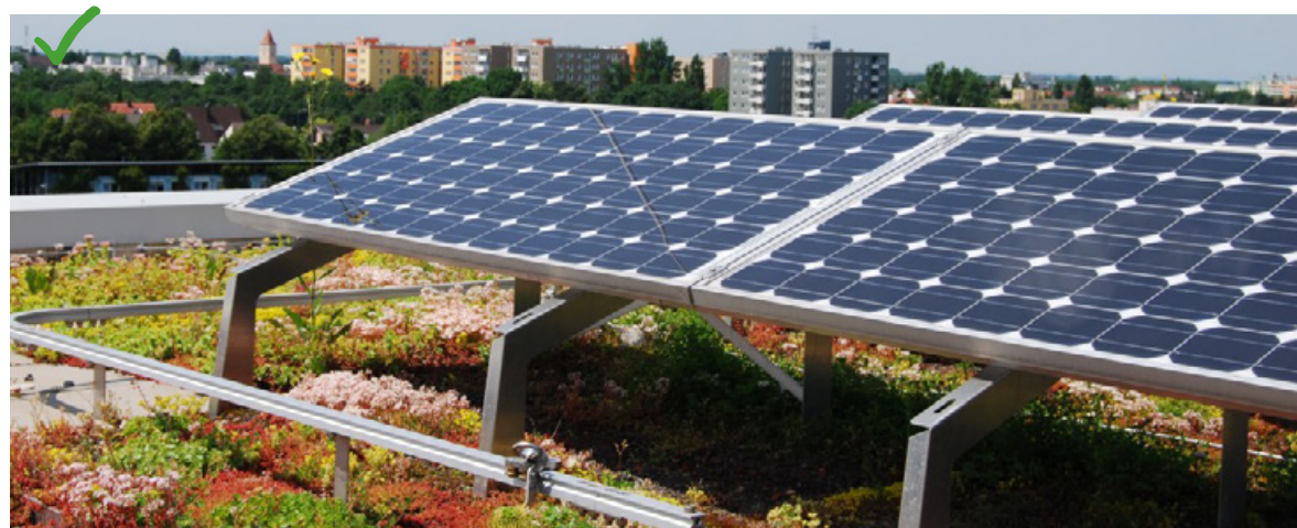
▲ Wel: geïntegreerde zonnepanelen gecombineerd met een groen dak.
