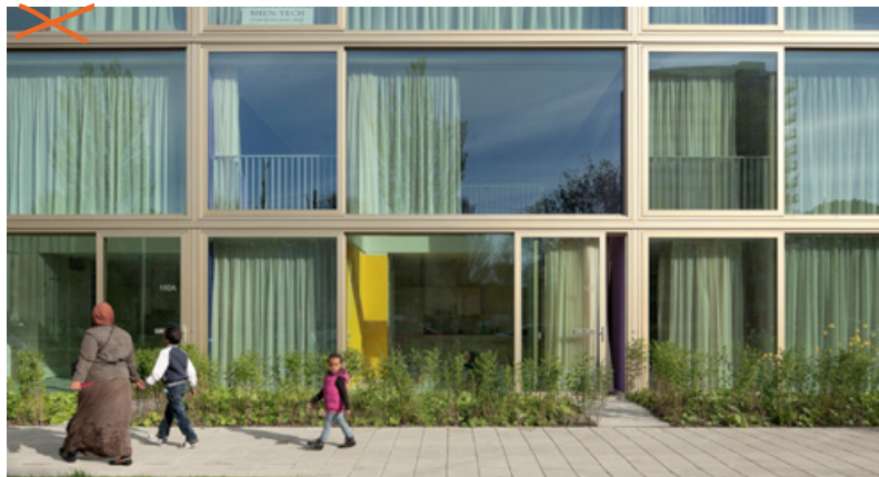
◄ Niet: veelvuldig gebruik van grote glasvlakken op begane grond bij woningen.
