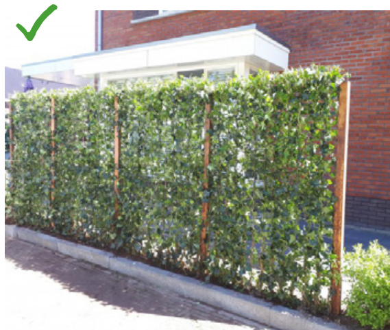
▲ Wel: Achtertuinen bij sociale huur minimaal een gaashekwerk met hедера
