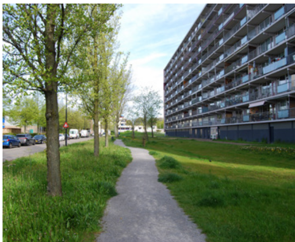
▲ Recent aangelegde wadi langs de Haydnlaan.
