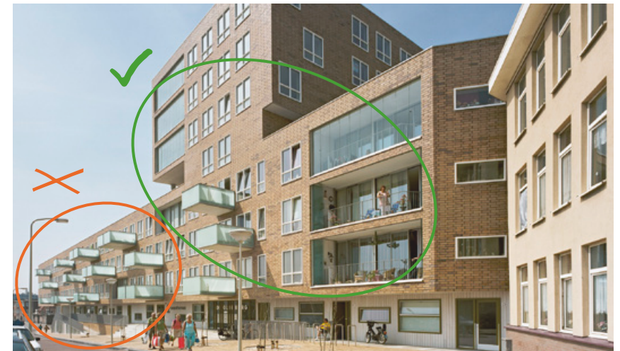
▲ Wel: variatie in type buitenruimte, loggia's dakterrassen en balkons. Niet: ver uitstekende balkons in een repeterend ritme en te laag beginnend zodat de openbare ruimte te veel overdekt wordt.
