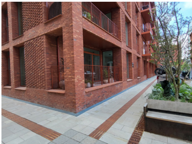
▲ Op de begane grond aan de straat wordt privacy voor de appartementen gecreëerd door gebouwde voorzieningen
