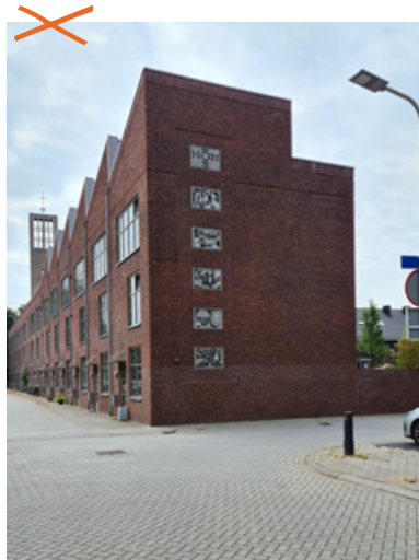
▲ Niet: blinde kopgevel
