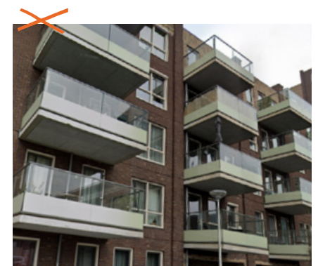
▲ Niet: te laag beginnende eentonig repeterende uithangende balkons.
